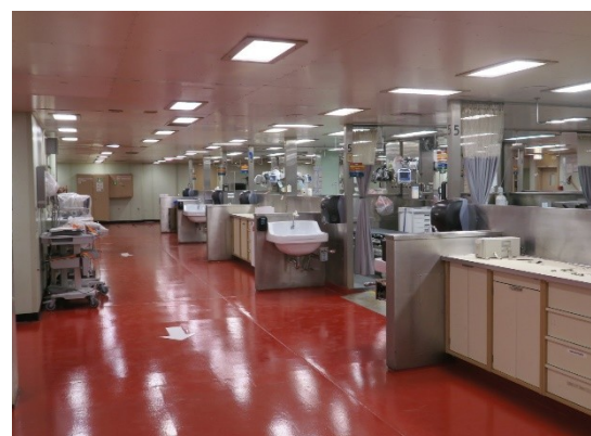
最初の患者受け入れ場所となる救急室 すべてが揺れても破損しないように固定され、床に段差を設けて洗浄液や血液など汚染が拡がらないよう工夫されている
