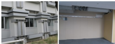
建て替えずに免震構造化(免震装置ブレード工法)
