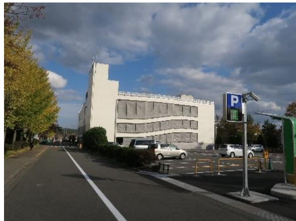
屋上にヘリポートをもつ防災倉庫 救命救急センターからすぐに立地している
