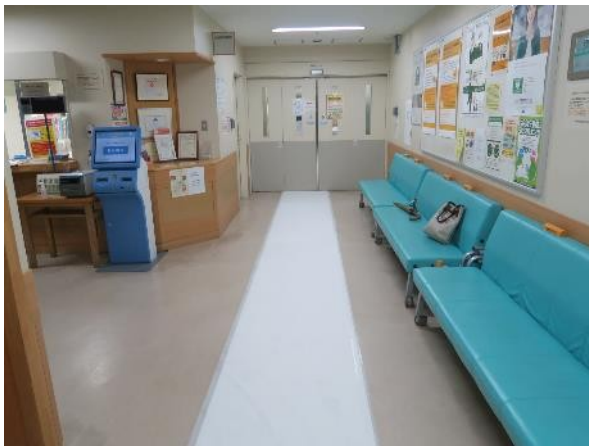
救命救急センターに至る廊下の養生
