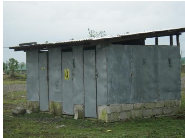
仮設住宅の集合トイレ
