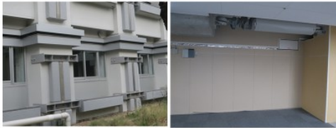
建て替えずに免震構造化(免震装置プレロード工法)
